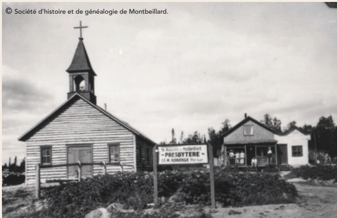
Église construite en bois rond à St-Augustin de Montbeillard, sur le chemin Perreault, à côté du presbytère.
